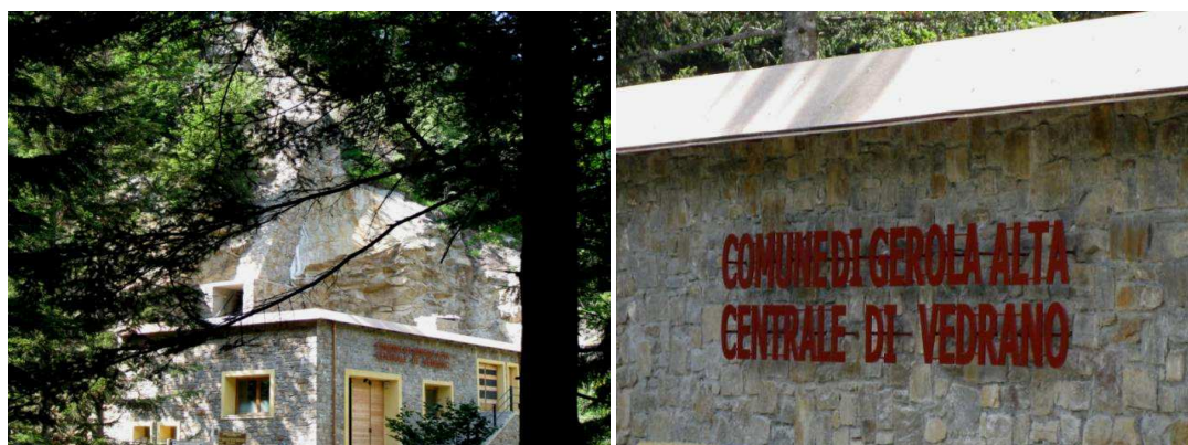
la nuova centralina idroelettrica del Comune di Gerola Alta
